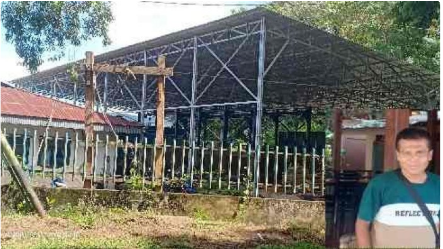
Kondisi Bangunan Pabrik Es di Kelurahan Tandurusa Tak miliki Ijin PBG
